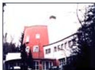
Rewaloryzacja budynku WEH Ambasady RP przy ul. An der Alteburger Muhle 6 w Kolonii (RFN)
