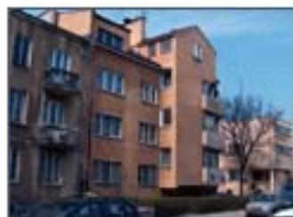
Budynek mieszkalny przy ul. Wiśniowej w Warsza- wie
