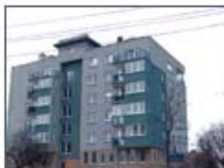
Budynek mieszkalny przy ul. Pęcickiej w Warszawie
