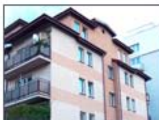
Budynek mieszkalny z garażami podziemnymi przy ul. Renesansowej w Warszawie
