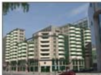
Budynek mieszkalno - usługowy przy ul. Żelaznej w Warszawie
